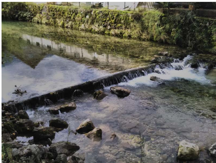
Slika 10: Primer pregrade in regulacije brežine na Belci v Bohinjski Bistrici.
